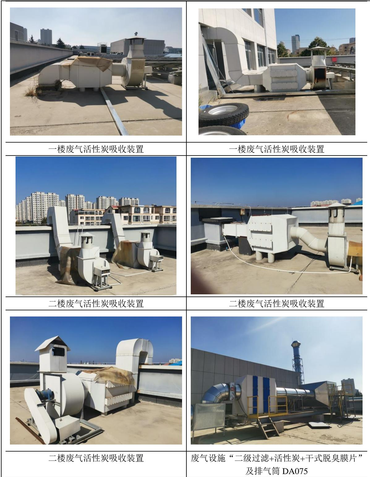
图 3-3 项目废气收集设施、治理设施及排气筒
